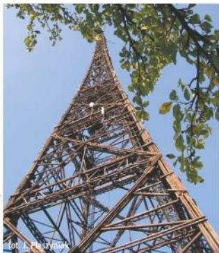
Wieża Radiostacji w Gliwicach
